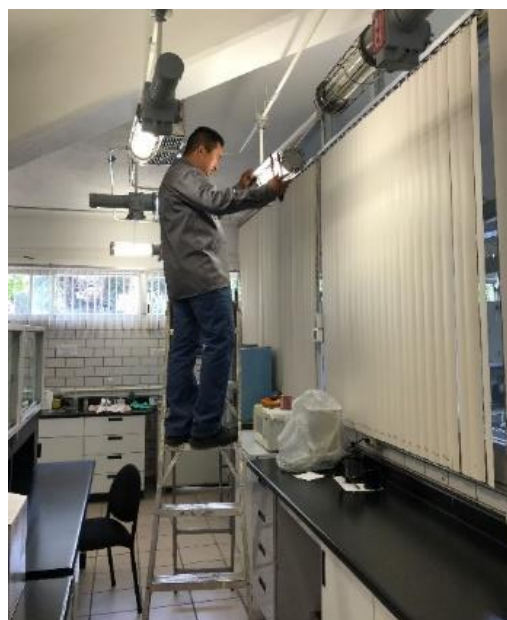
Fig.2. Adaptación LED en gabinetes de luminario tipo anti-explosivo.Lab. de Ecología Química de Insectos del CeProBi del CeProBi
