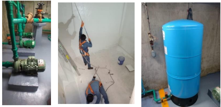
Mantenimiento a Cisterna, Cuarto de Bombas e Hidroneumáticos
