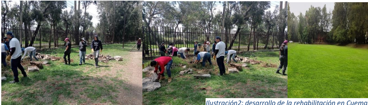
Ilustración 2: desarrollo de la rehabilitación en Cuernavaca
