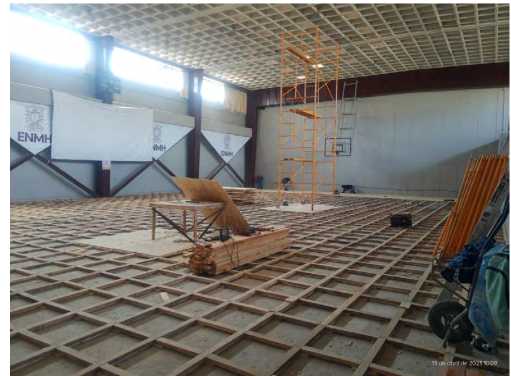
Trabajos de sustitución de la duela
