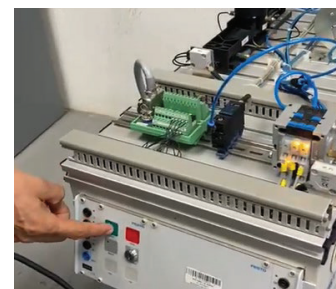
Figura 1F Tablero de control de la estación MPS.
